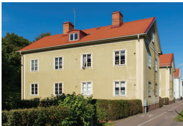
Det östra huset i Grävlingen 1 sett från öster. Takkupan är ursprunglig och viktig att bevara i sin nuvarande utformning. (D2015-1144)
