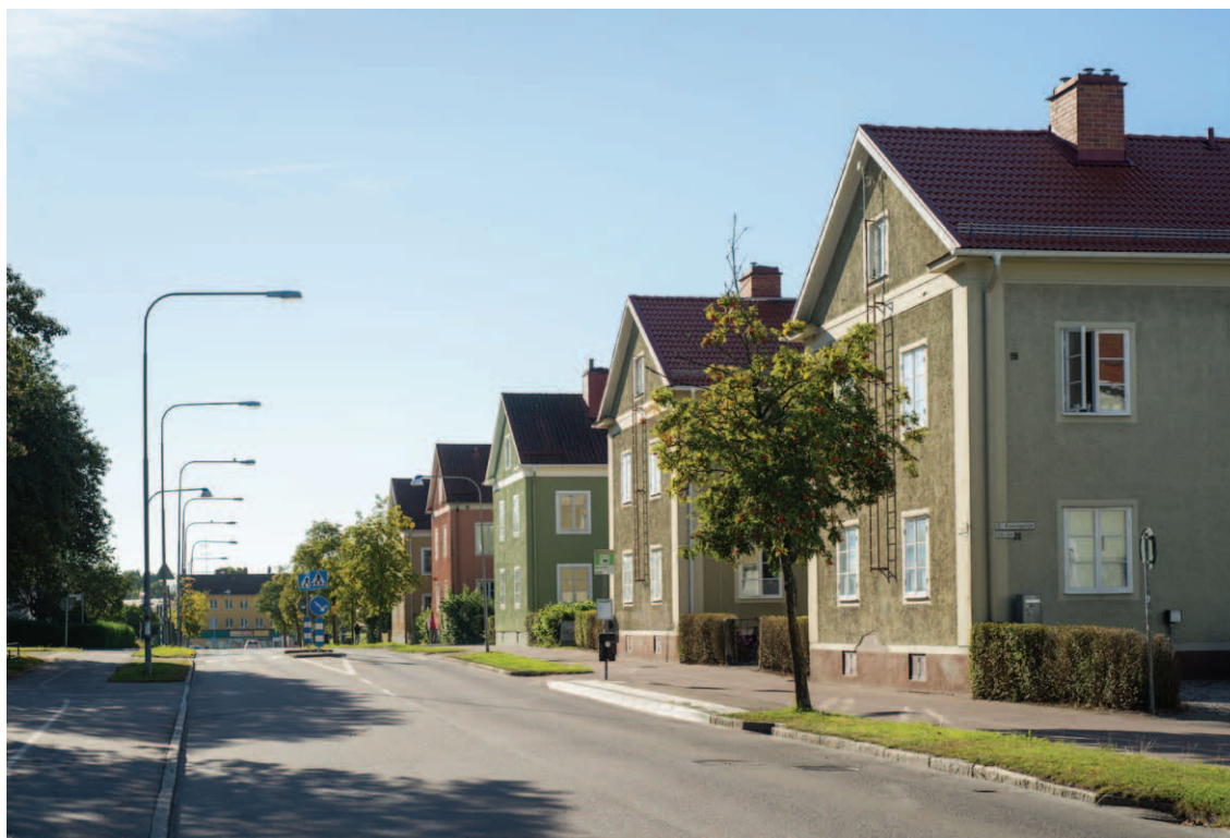
Både kvarteret Grävlingen och Vesslan har genom sin placering i stadsrummet och sina relativt välbevarade exteriörer ett högt kulturhistoriskt värde. De skapar tillsammans ett stadsutsnitt som i stort sett är oförändrat sedan stadens expansion österut i början på 1930-talet. (D2015-1153)
