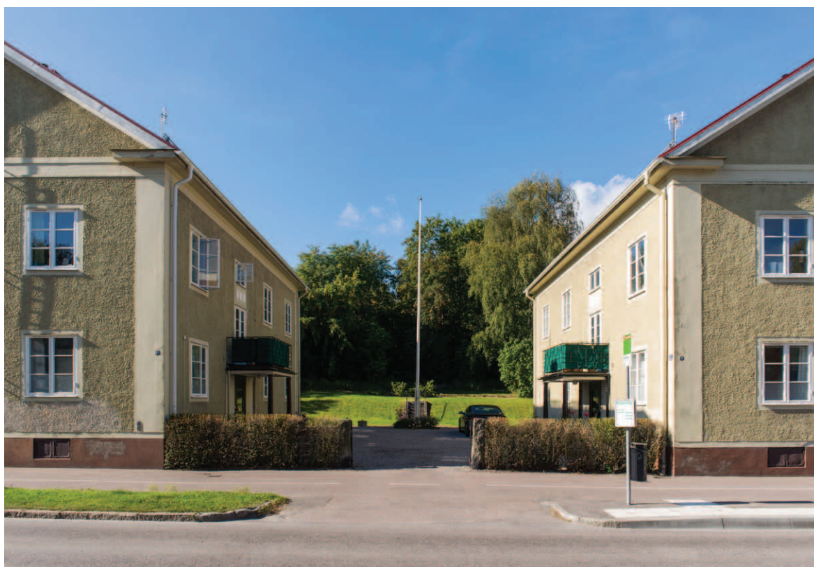
Fastigheten Grävlingen 1 sedd från norr. Byggnaderna är två speglade kopior av varandra med en gemensam gårdsplan på ytan mitt emellan. (D2015-1139)
