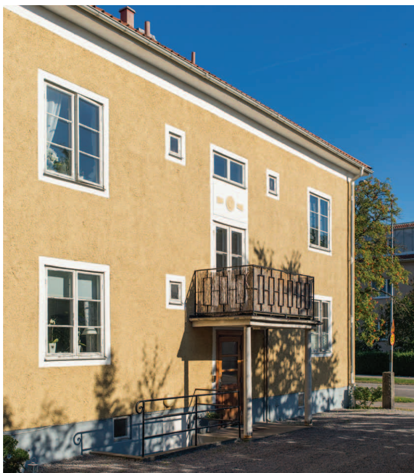
Grävlingen 4. Hela entrépartiet med port, balkongdörr, räcke samt fönster är ursprungliga och av högt kulturhistoriskt värde. (D2015-1147)
