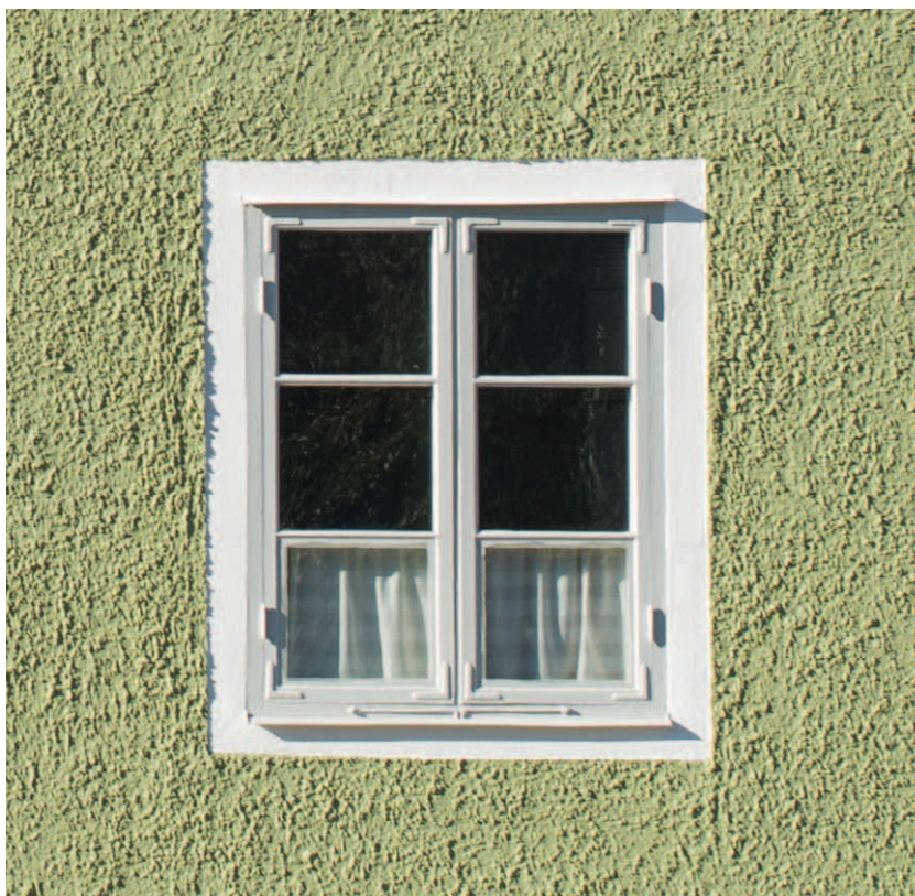
Fönsterparti på Grävlingen 2. Fönstren är ursprungliga med tidstypiska beslag och har därför ett högt kulturhistoriskt värde. (D2015-1152)
