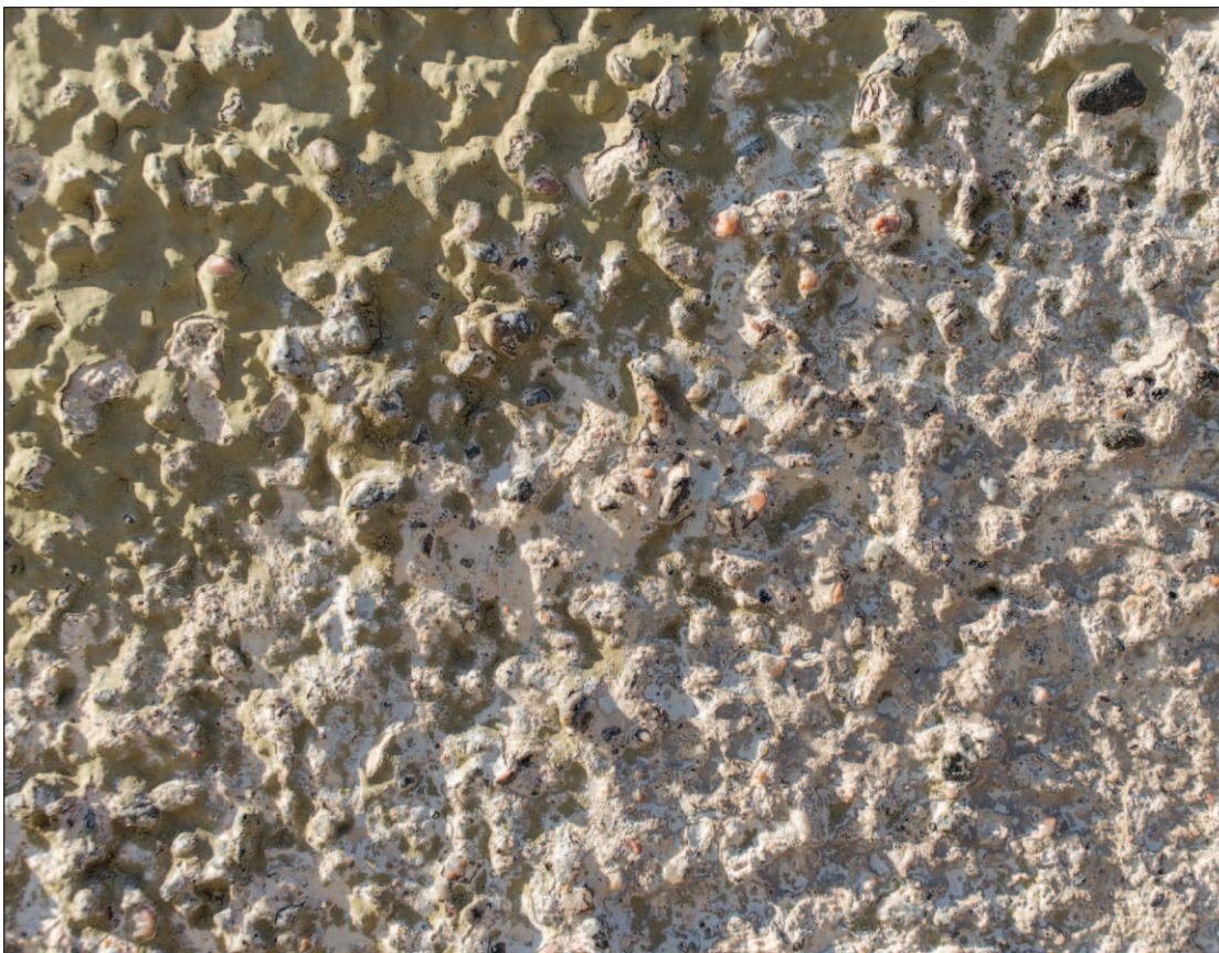
Spritputsen är utförd med ballast av naturgrus som har en varierande kornstorlek. Detta ger putsen en levande och varierad struktur med mjuk yta. (D2015-1151)
