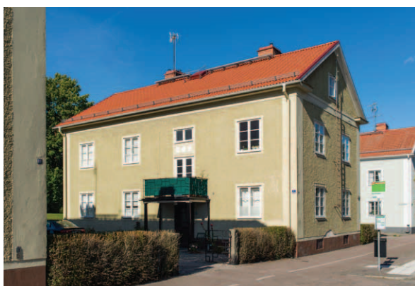
Det västra huset i Grävlingen 1 sett från öster. Hörnkedjorna, fönsteromfattningarna samt listverket som delar av gavelfasaden i slät puts är starkt karaktärsskapande. Notera grinden in till gårdsplanen som har samma mönster som balkongräckena. (D2015-1140)
