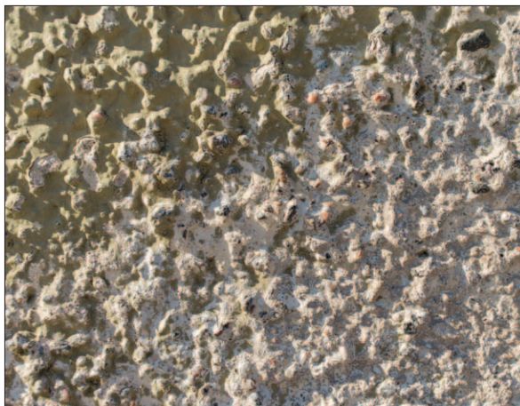
Spritputsen är utförd med ballast av naturgrus som har en varierande kornstorlek. Detta ger putsen en levande och varierad struktur med mjuk yta. (D2015-1143)
