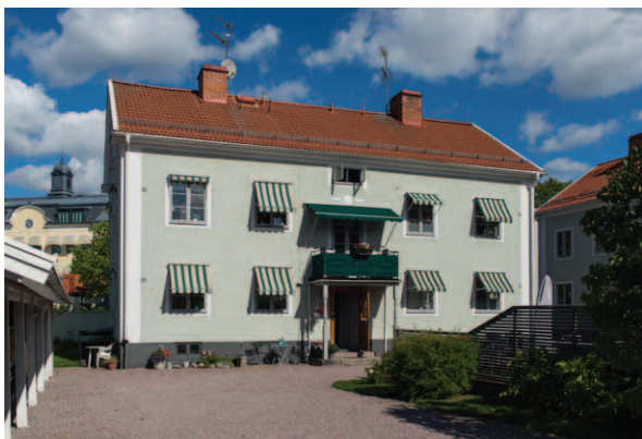
Det västra huset i Vesslan 3. Notera symmetrin i fönstersättningen och portens placering. (D2015-1136)
