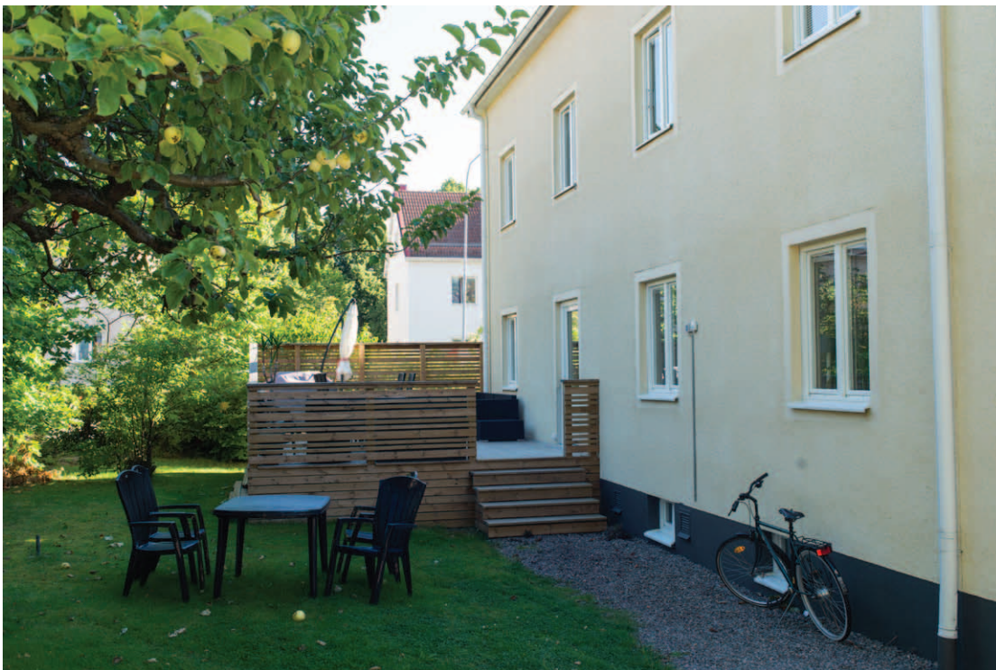
På baksidan finns en uteplats i direkt anslutning till fasaden, med en altandörr från en av lägenheterna. (D2015-1149)
