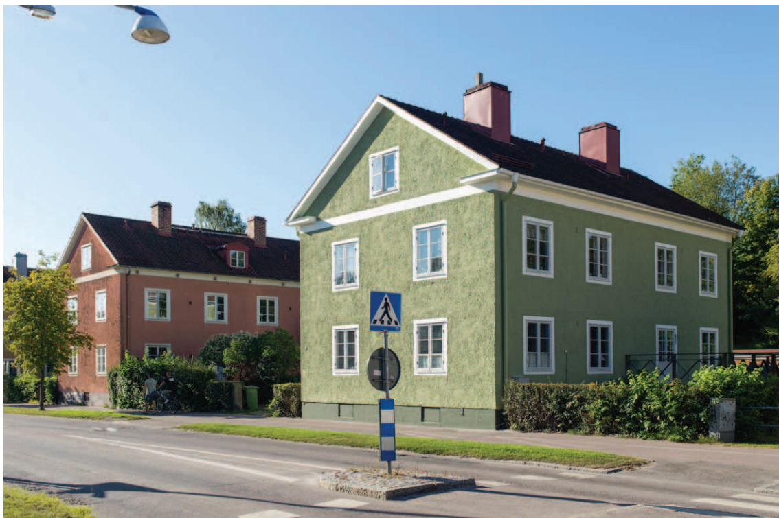
Grävlingen 2 närmast i bild och Grävlingen 3 till vänster. Grävlingen 2 är nyligen omfärgad. (D2015-1145)
