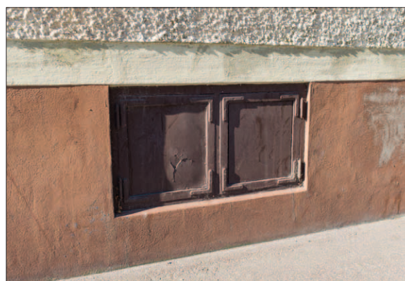
De igensatta källarfönstren har fortfarande kvar sina bågar. Fönsterplaceringen är gjord efter övriga våningars fönsteröppningar och en viktig del av arkitekturen. (D2015-1141)
