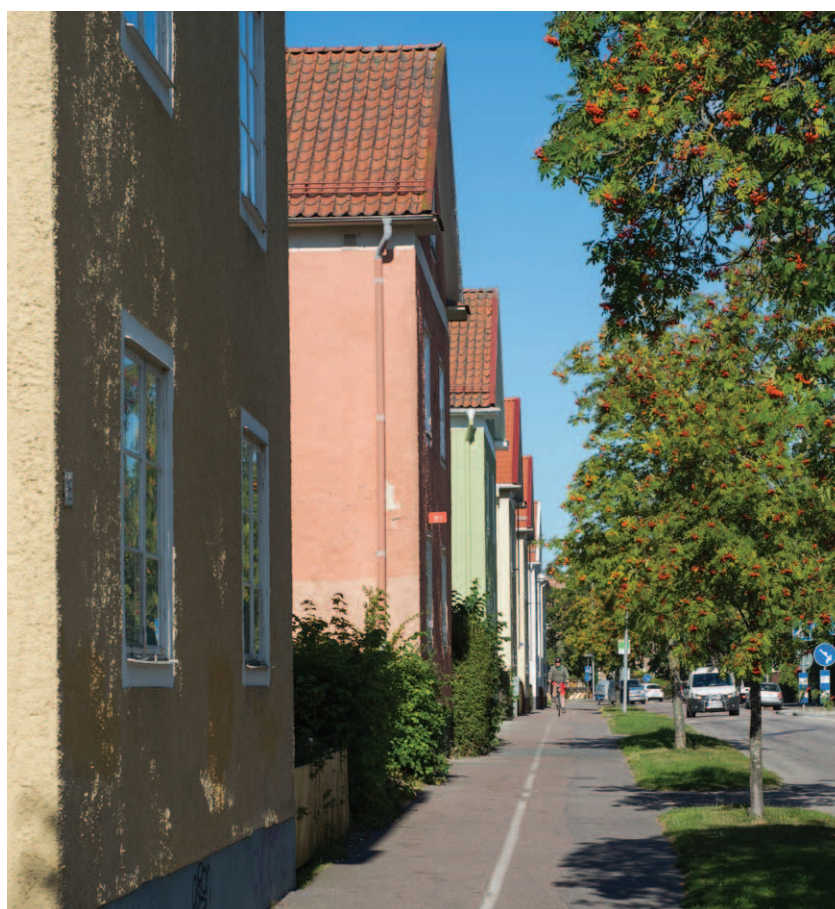
Fönstren ligger i liv med fasaden vilket är mycket viktigt för siktlinjen från en snäv vinkel för förbipasserande längs den närliggande trottoaren. (D2015-1154)
