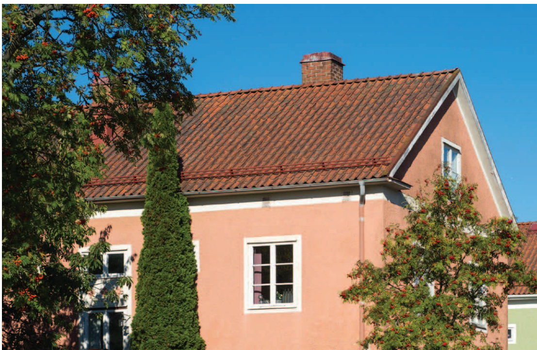
Det östra takfallet på Grävlingen 4. Takfallet saknar takkupor och det enkupiga takteglet är sannolikt ursprungligt. Detta tillsammans med skorstenar i ursprungligt skick är av högt kulturhistoriskt värde. (D2015-1146)
