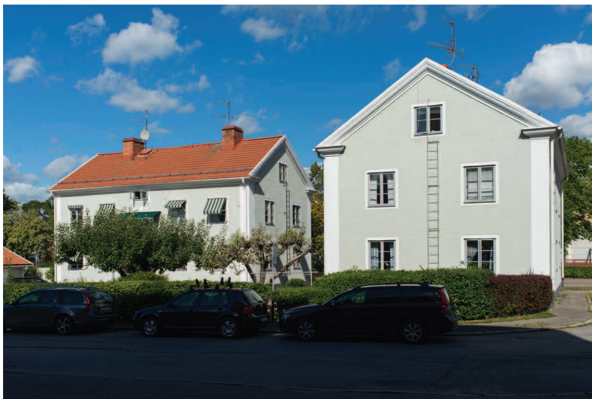
Den kraftiga profilerade taklisten är ett viktigt arkitektoniskt element som tillsammans med avsaknaden av takkupor är viktiga för helheten. Notera att skorstenarna inte är inklädda i plåt. (D2015-1132)
